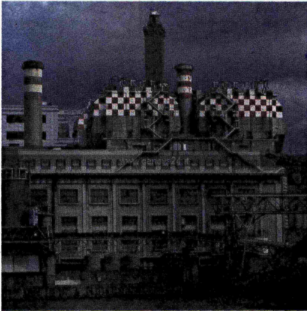
IN CITTA La centrale Enel a carbone a Sampierdarena
