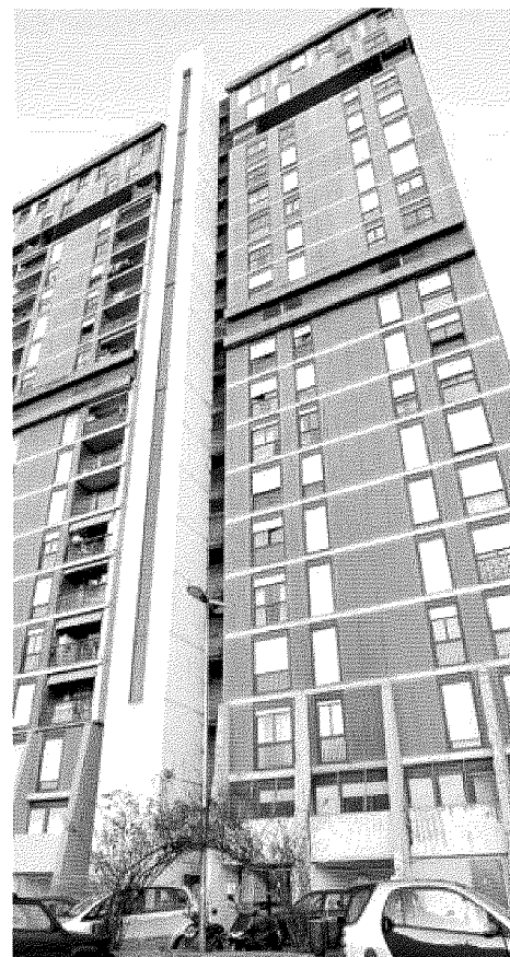
Una delle facciate della "Diga" di Begato, edilizia popolare anni Settanta
