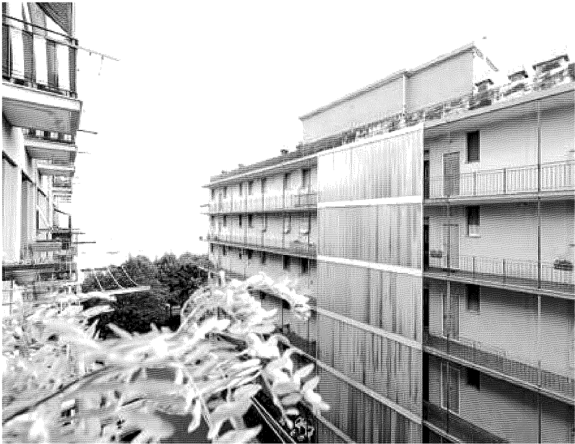
Il complesso delle case popolari di via Lugo a San Teodoro
