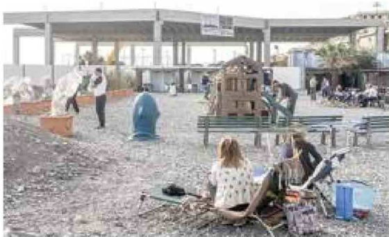
La copertura in costruzione
